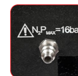
Test szczelności z azotem
